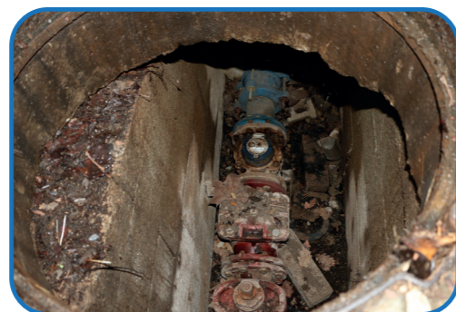
Le compteur d'eau compte le nombre de litres d'eau potable consommés dans les bâtiments.
